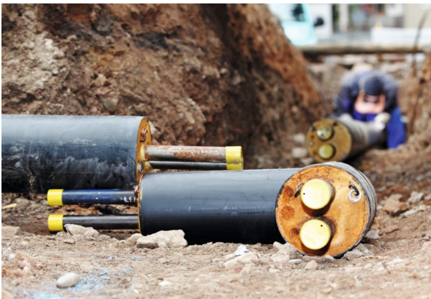
Nah- und Fernwärmenetze werden wieder ausgebaut.
