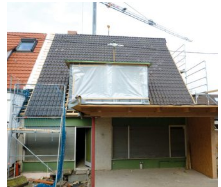
Das Haus als Baustelle.
