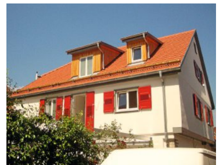
Das sanierte Haus von außen.
