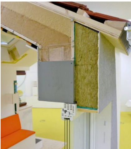
Musterhaus im Wissenszentrum Energie in Ludwigsburg. Bauteilanschnitt und Wärmebrückensimulation.
