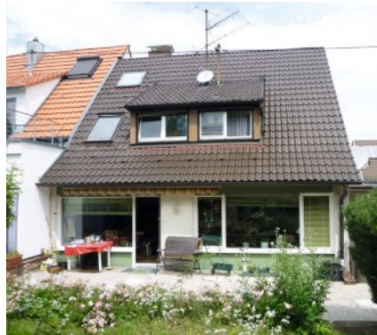
Das Haus vor der Sanierung.
