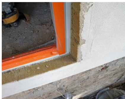
Dämmung im Bereich der Fachwerkwände.
