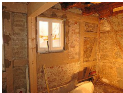
Der Altputz wurde entfernt und ein neuer Kalkputz angebracht.
