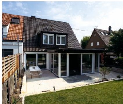
Das Haus nach der Modernisierung.
