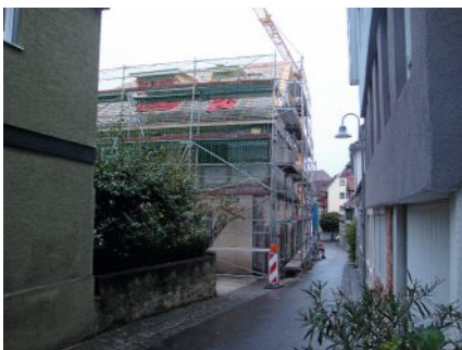
Die Denkmalbehörde hat das Freilegen der Bruchsteinaußenwände im Erdgeschoss gefordert.
