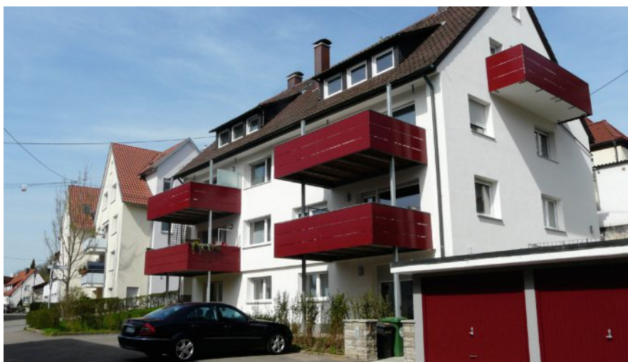
Bei mehreren Eigentümern in einem Gebäude ist vorausschauende Absprache sehr wichtig. Foto: Elke Hesse
